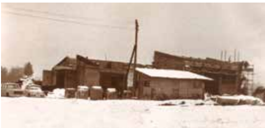
Šola v času gradnje
