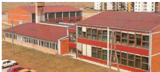
Šolska stavba leta 1985
