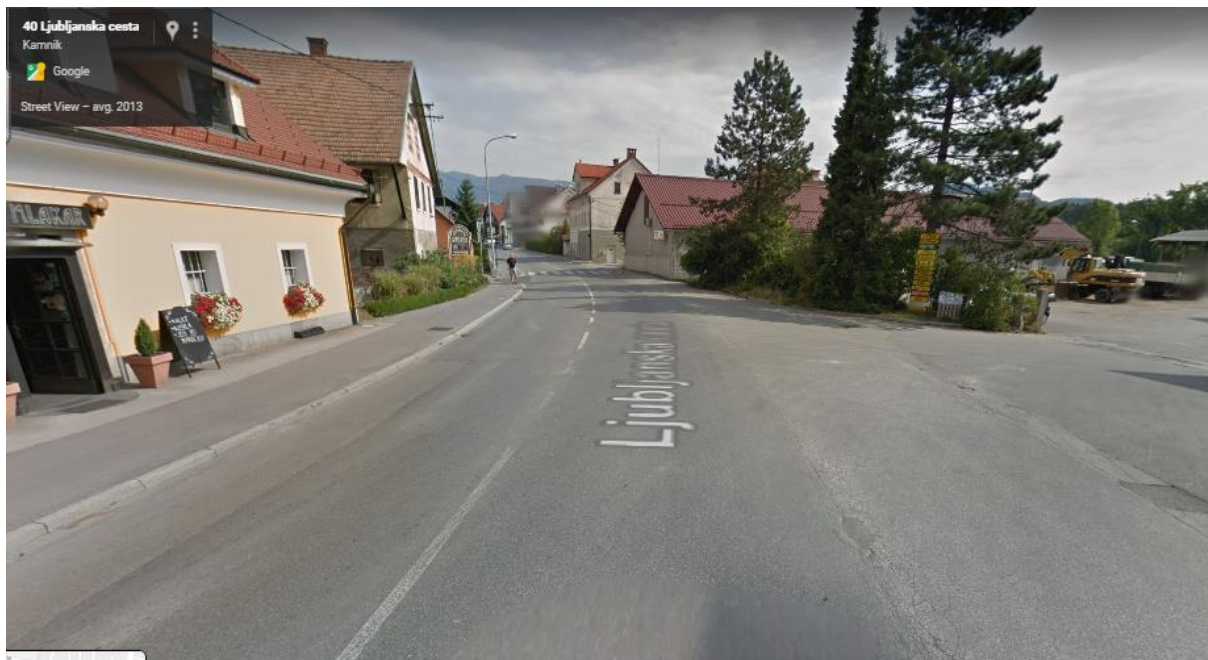
Slika 6: Nevarno prečkanje cestišča na Ljubljanski cesti pri gostišču Mlakar (vir: Google maps – street view)
